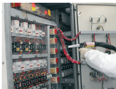
Nettoyage armoire électrique
